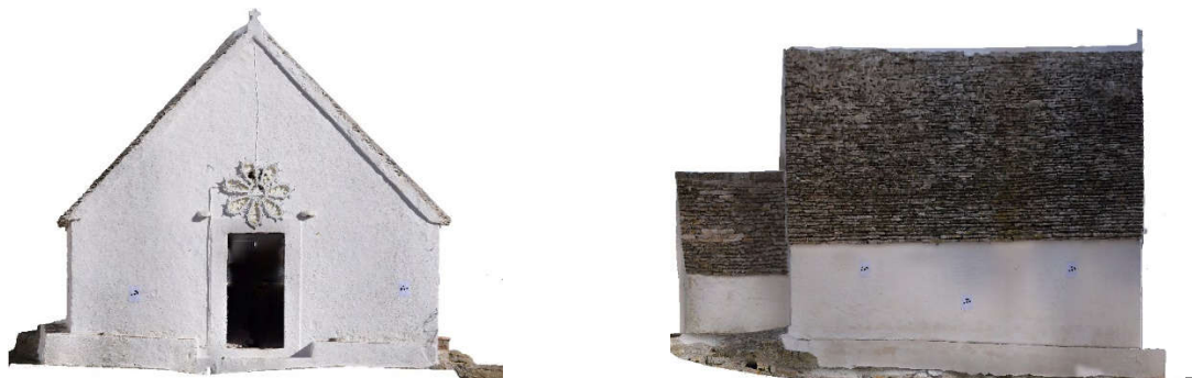
Figura 9. Nella figura sono riportate due ortografie dedotte dal rilievo fotogrammetrico del 2023 che rappresentano sia il prospetto principale che quello laterale sinistro.
