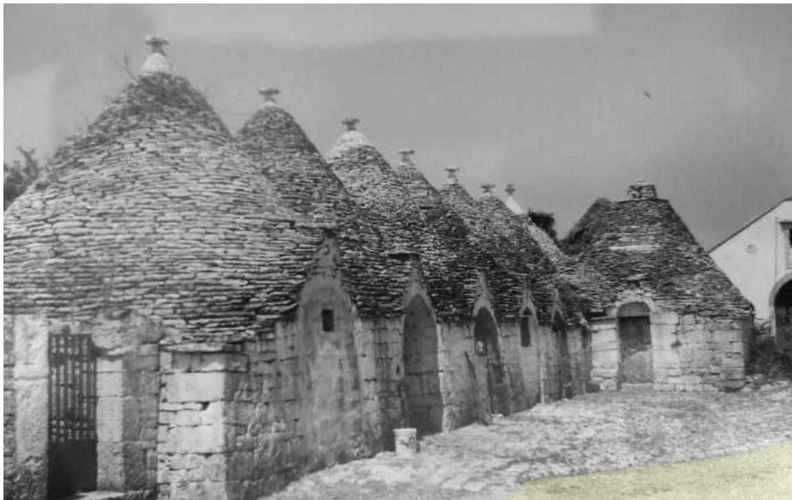
Figura 7. Nella figura appare evidente la presenza di un suolo pavimentato, ottenuto con il posizionamento di lastre di pietra che arrivano a ridosso dei trulli e che descrivono una sorta di camminamento pedonale da distinguersi rispetto quello centrale che sembrerebbe caratterizzato da un fondo battuto e carrabile (vedi figura destra).
